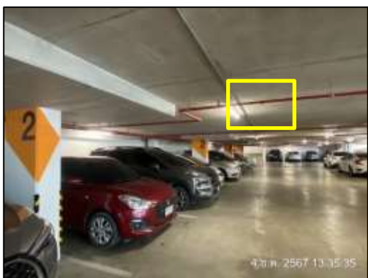
ภาพที่ 37 หัวกระจายน้ำดับเพลิง
