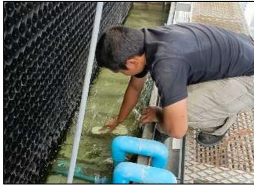
ภาพที่ 47 ทำความสะอาดท่อฝังเข็ม
