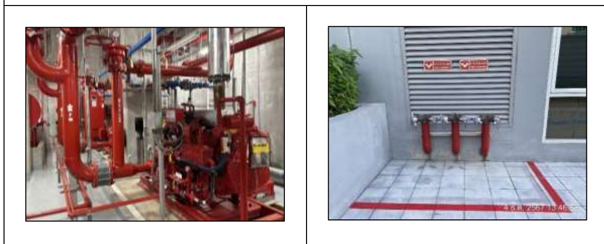
ภาพที่ 33 ระบบน้ำดับเพลิง
