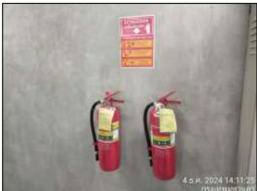
ภาพที่ 36 ถังดับเพลิงแบบมือถือ
