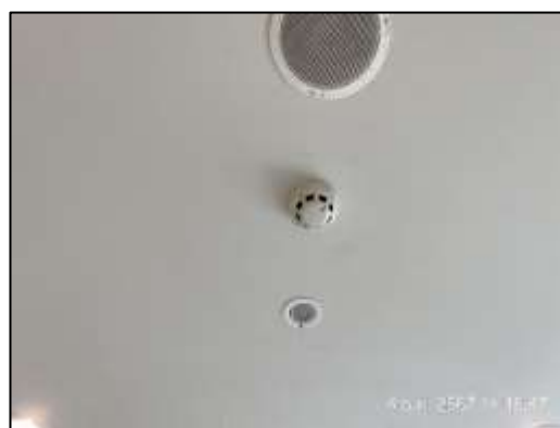
ภาพที่ 39 เครื่องตรวจจับควัน
