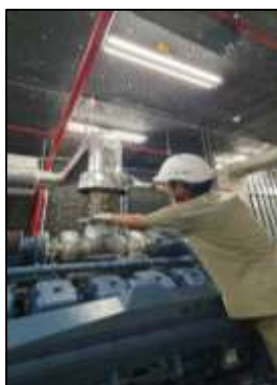
ภาพที่ 30 ตรวจสอบระบบท่อไอเสียจากห้องเครื่องกำเนิดไฟฟ้า
