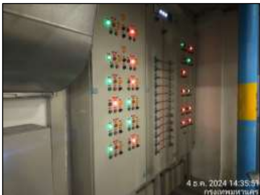
ภาพที่ 11 ระบบมอเตอร์ไฟฟ้าสำหรับระบบบำบัดน้ำเสีย
