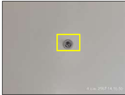
ภาพที่ 37 หัวกระจายน้ำดับเพลิง
